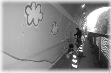
真米トンネル内
